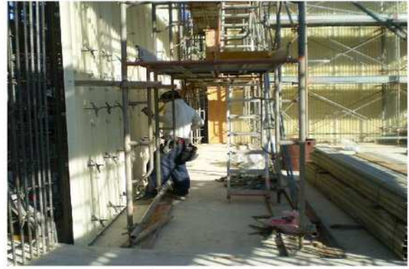
型枠組立状況
